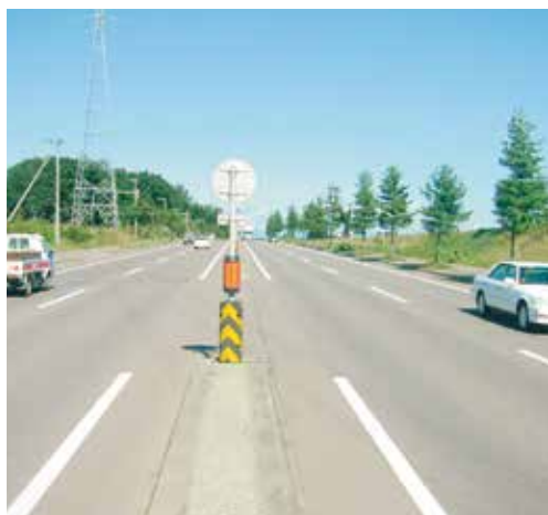
片側 2 車線道路
