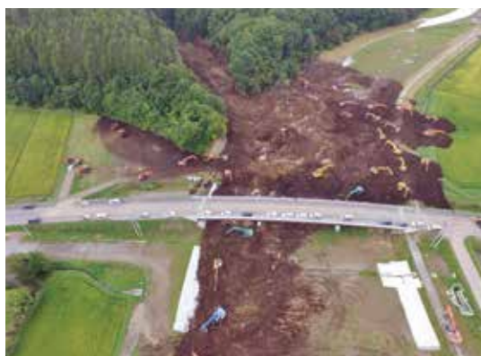
ほろないぼし 厚真町幌内橋の上空からの様子
