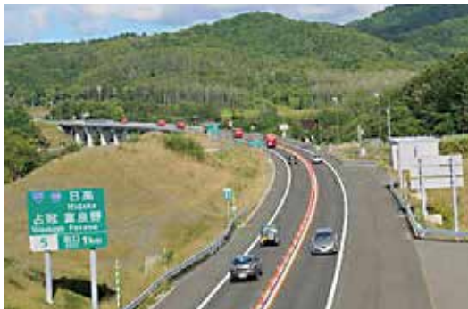
高速道路(道東自動車道)
