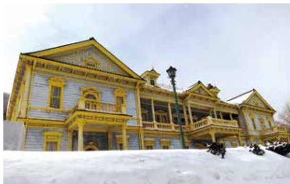
③ 旧函館区公会堂：函館市
