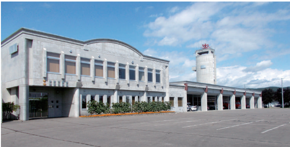
消防署の建物
