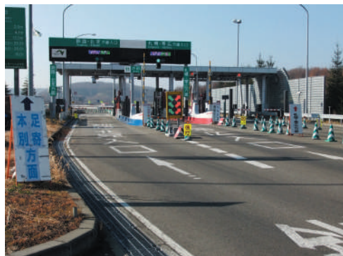
池田インターチェンジ
