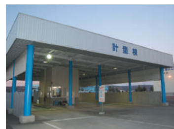
トラックスケール（計量機）
