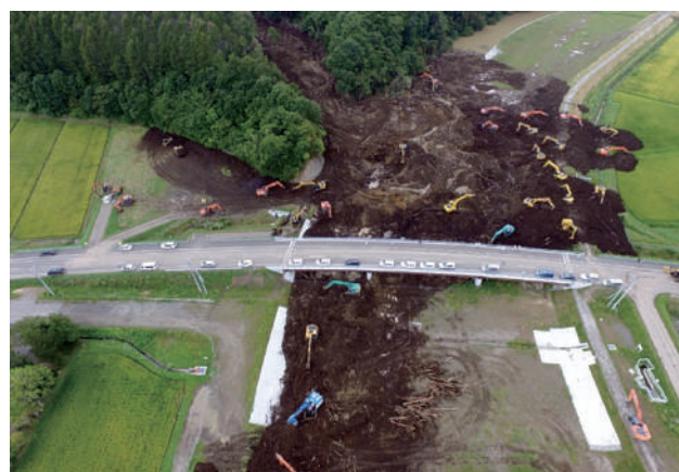
緊急復旧作業 (厚真町・厚真川)
