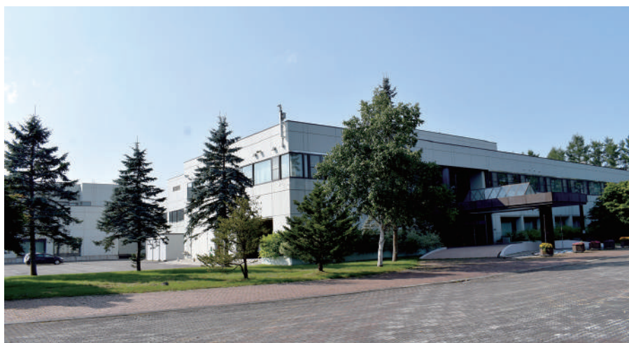
中十勝浄水場
