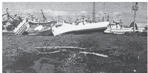
【豊頃町大津漁港における東日本大震災の被害】
